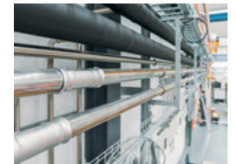
Geberit Mapress Therm in geschlossenen Kühl- bzw. Kältekreisläufen.
