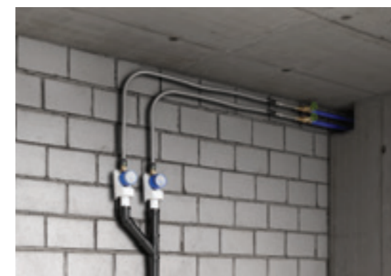
Verbindungsleitungen zu ungenutzten Gebäudeteilen
