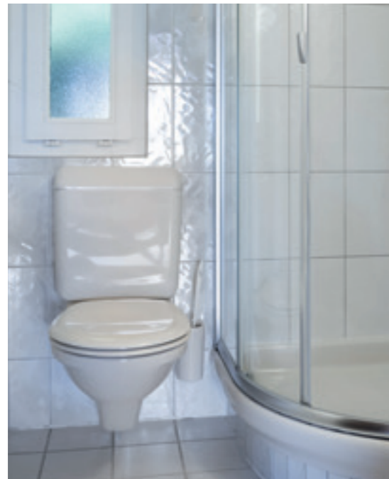
VORHER Einbausituation mit Aufputzspülkasten
