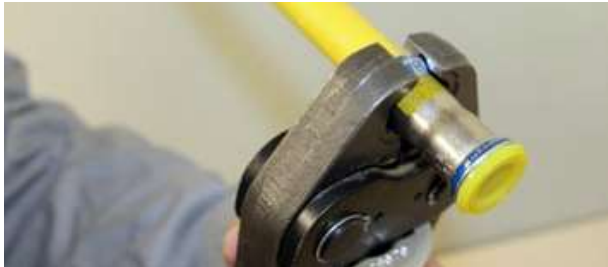
Bild 18: Pressvorgang mit Pressbacke d_a 12 – 35 mm
