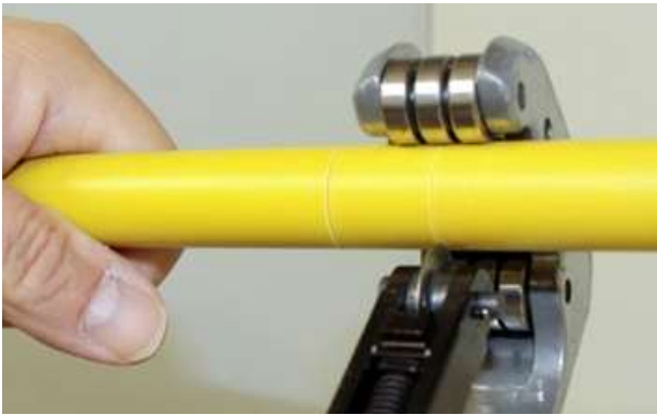
Bild 7: Anritzen des Kunststoffmantels
