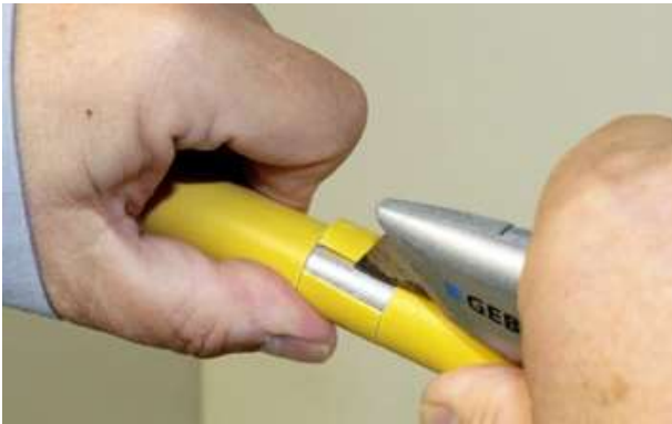
Bild 8: Schlitzen des Kunststoffmantels
