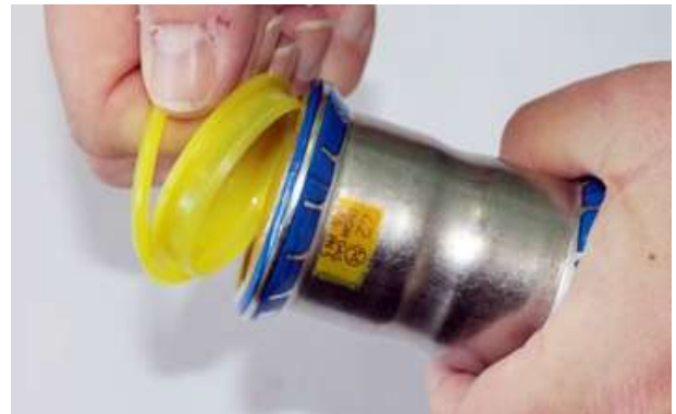
Bild 15: Entfernen der Schutzkappe und Prüfen des Dichtrings
