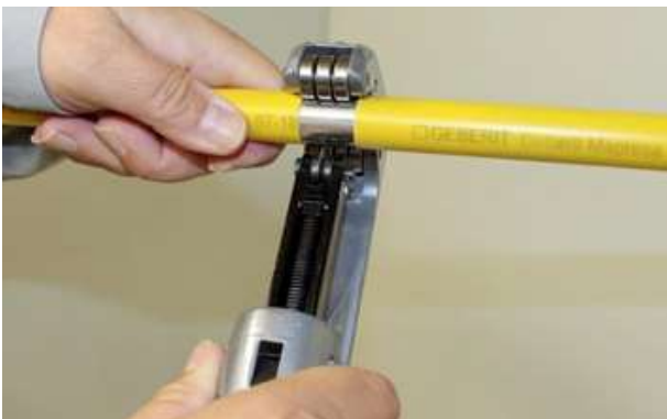
Bild 9: Trennen von Rohr bei entferntem Kunststoffmantel
