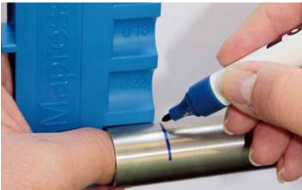
Bild 14: Markieren der Einschubtiefe mit Einschubtiefenlehre
