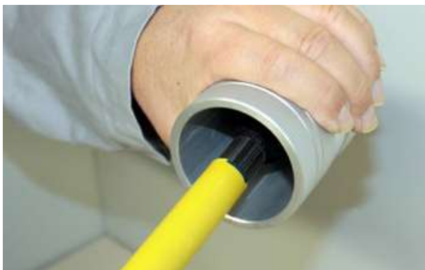
Bild 11: Innenentgraten mit Handentgrater
