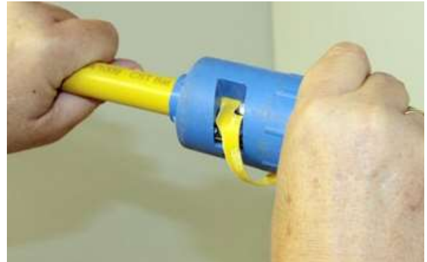
Bild 10: Abmanteln des Kunststoffmantels auf Einschubtiefe
