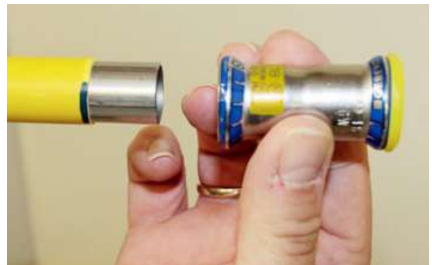
Bild 16: Ineinanderschieben von Systemrohr und Pressfitting
