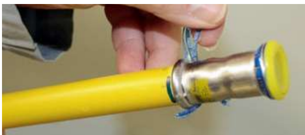
Bild 20: Pressindikator lösen
